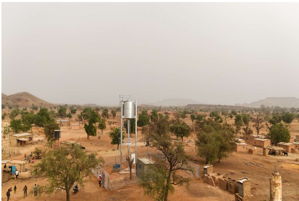
Photo : vue aérienne de l'AEPS du village de Sorgho Yarcé dans la commune de Kongoussi
