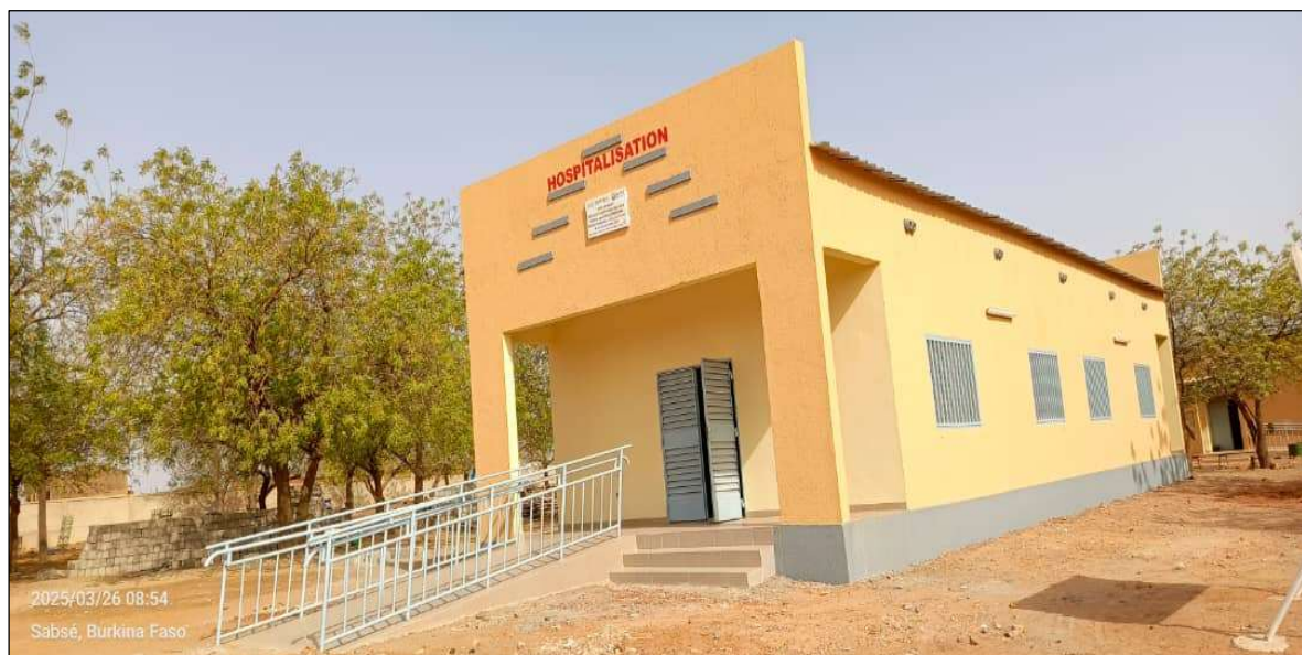
Une salle d'hospitalisation construite à Sabcé par notre projet en consortium avec WHH et Coopi.
